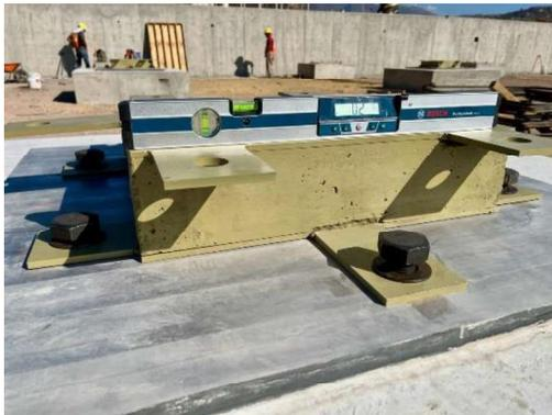
*Verificación con inclinómetro digital*
